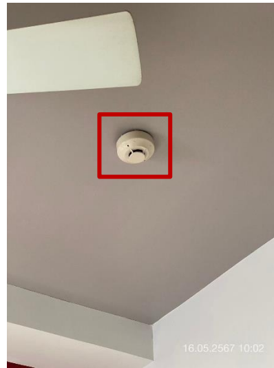
ภาพที่ 22 แสดง Smoke Detector ภายในห้องพัก
