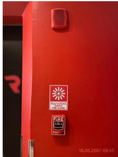
ภาพที่ 8 แสดงสัญญาณเตือนภัยแบบมือดึง
